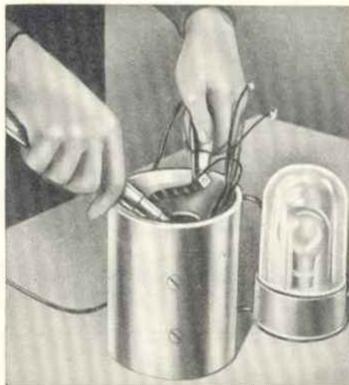
Obraz 186. Zkouška zkratem se žárovkou
